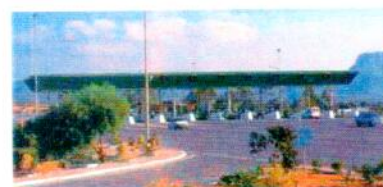
Etude de mise à péage de l'autoroute Tunis – M'saken
